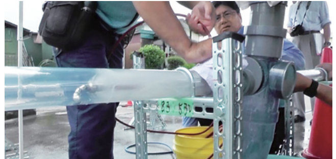
写真3 下流からの洗浄状況
