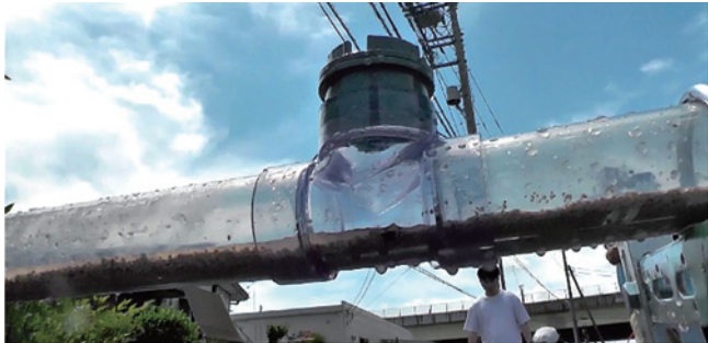
写真2 上流からの洗浄後堆積状況
